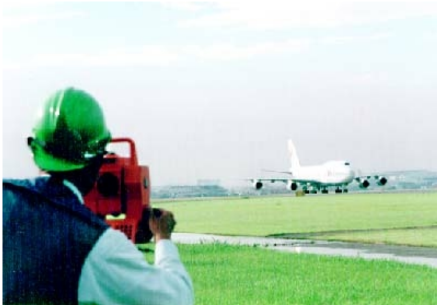
LLZ (着陸誘導装置) の設置
